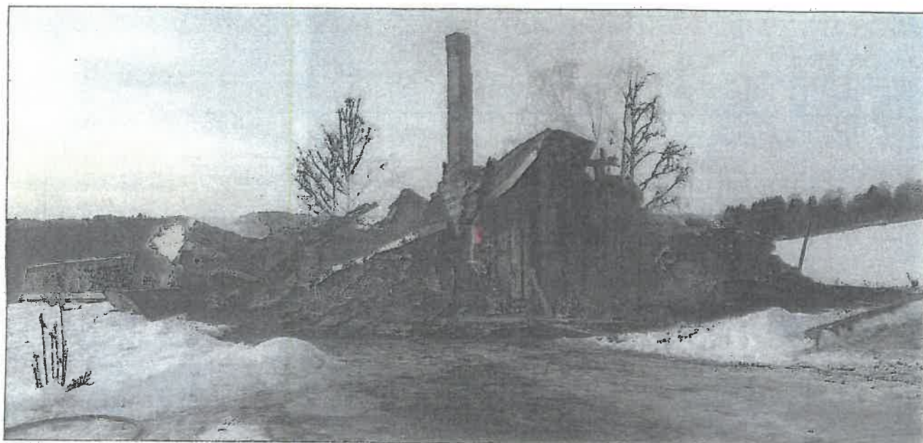
BRANN: Eneboligen på Rudshøgda brant helt ned til grunnen.
